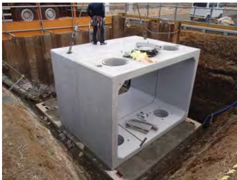
【写真】地下貯水槽の設置（緑区）
