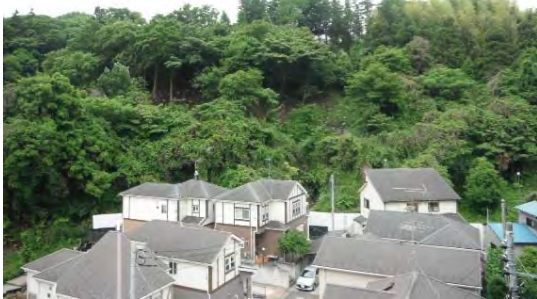
【写真】法面の整備 （保土ヶ谷区/川島特別緑地保全地区）
