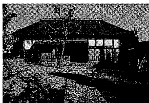
●旧奥津家長屋門
