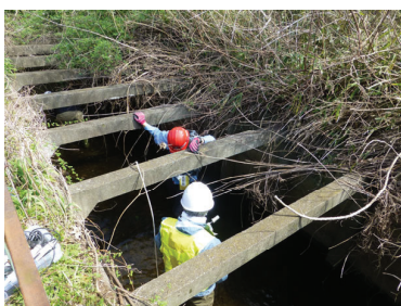
一部暗きよ化されたコンクリート製の水路
