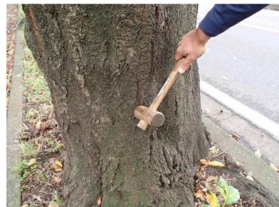
木槌による打診状況
