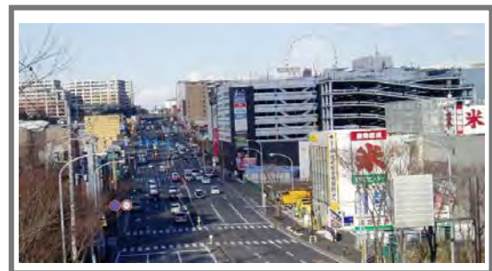
横浜北部新都市中央地区（港北NT） 土地区画整理事業（完了）
