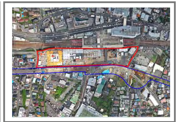
二俣川駅南口地区 市街地再開発事業（事業中）
