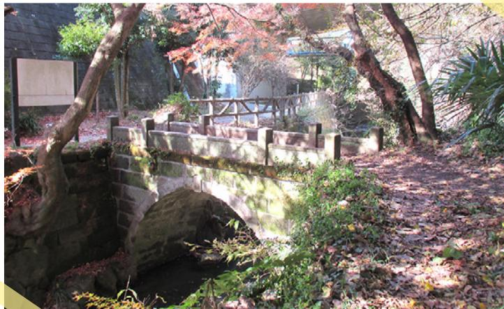
いたち川に架かる、幅1.4m、橋長5.5mのアーチ型の石橋で、石造橋としては市内最古と考えられ、周囲の落ち着いた水辺と共に歴史的景観を残している。既に移転した白山神社の参道橋であったと考えられ、建築年代は明治中期～大正4年以前と推定されている。かながわの橋100選に選出されており、平成13年には市認定歴史建造物に認定された。
