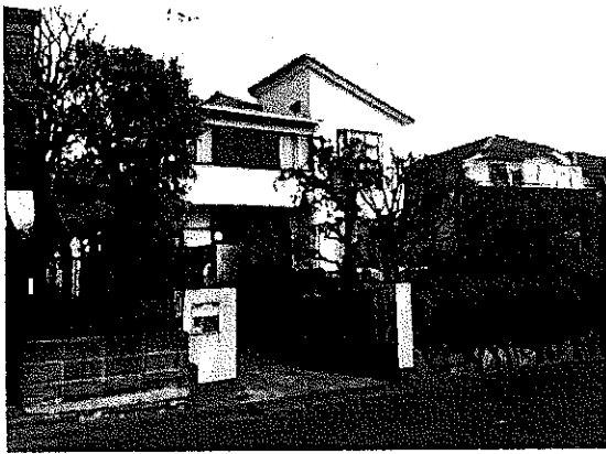
外観 (南側から)
