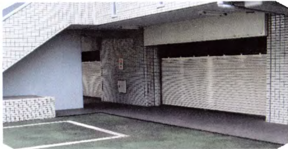
正面玄関 (現況写真)
