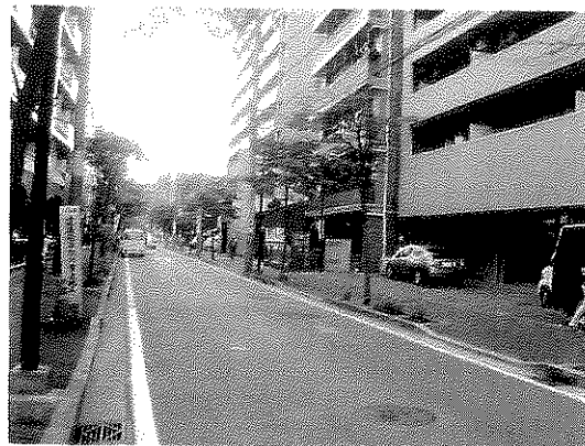
近年通りの両側にマンションが建ち並び、街並も変化してきている。
