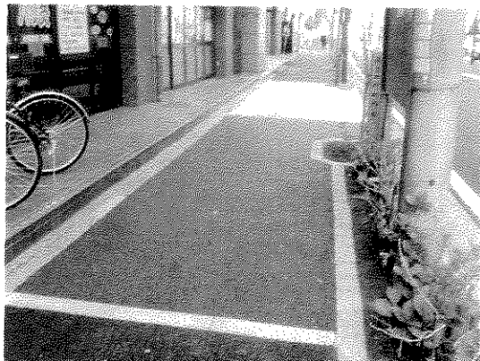
区役所・土木事務所の協力によりシンボルスポット周辺の歩道舗装の設置実験を行った。
