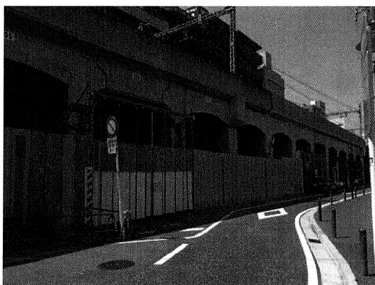
候補地 D 現況写真
