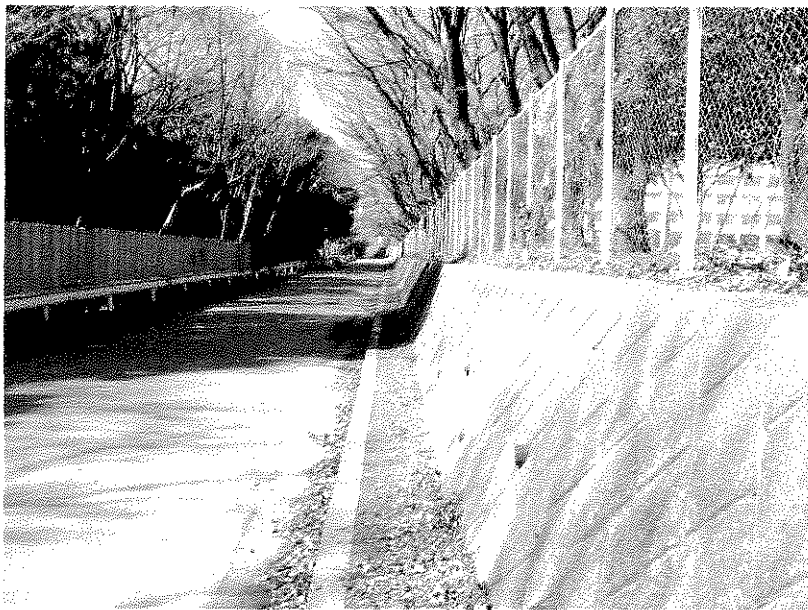
外周道路（右手が旭高校、左手が川井緑地で鉄板塀の切れた先が不法投棄場所）
