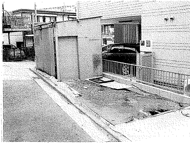
わくわく広場予定地(旧消防器具置場)
