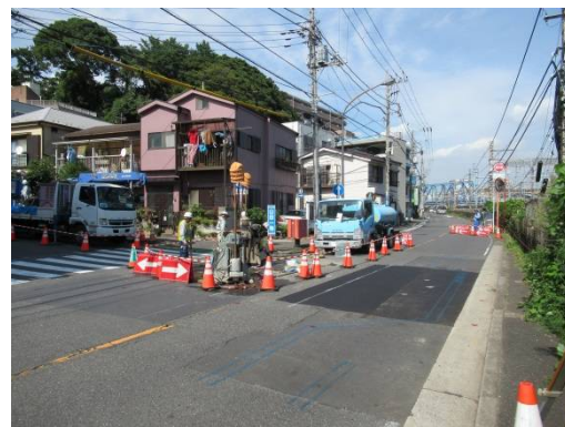
下水道工事状況
