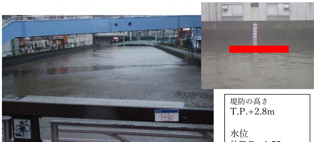
幸橋付近の帷子川の状況
