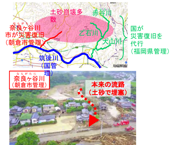
国が準用河川の災害復旧を代行することが想定される例 （平成29年九州北部豪雨（福岡県・筑後川水系））
