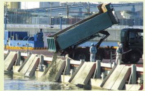
焼却灰を廃棄する様子
