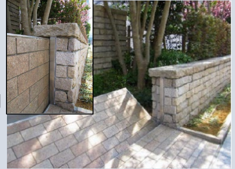
▲ 防水板の設置
