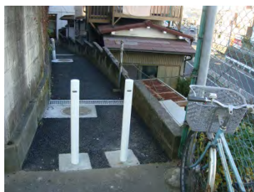
三春台防災まちづくり（整備後）
