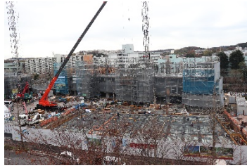
建設中の複合公共施設
