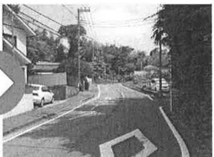
図表25 モデル地点② 施工後
