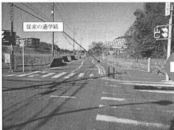
図表20 施工前の道路
