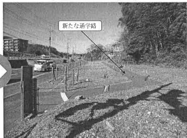
図表21 施工後の道路
