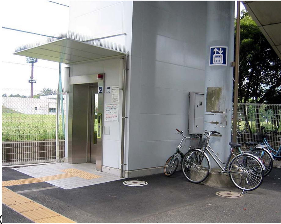
エレベーターの新設(シーサイドライン・産業振興センター駅)
