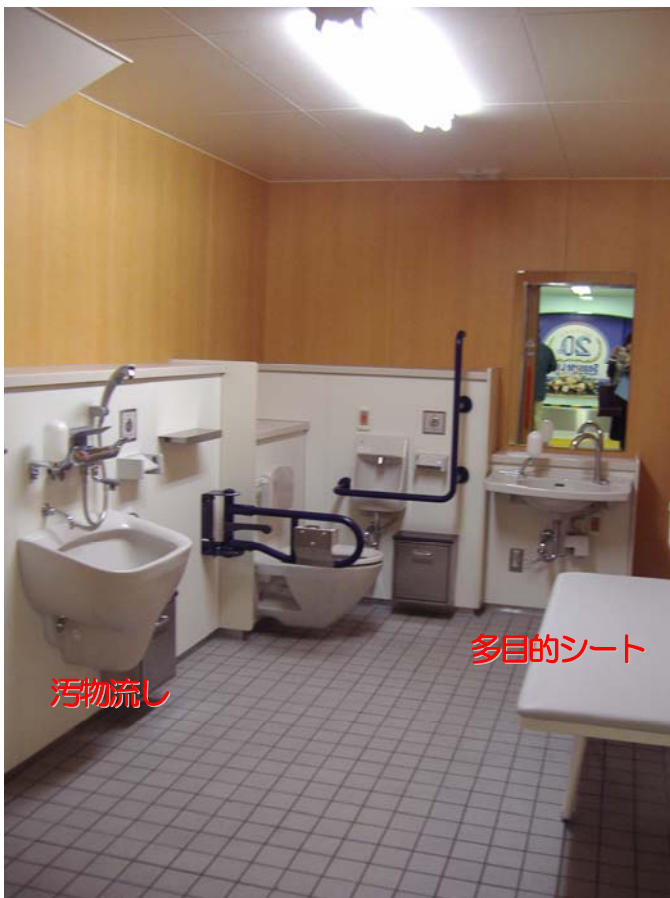
多目的トイレの新設(シーサイドライン・並木中央駅)
