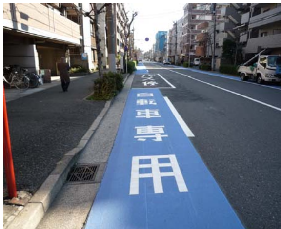
鶴見区潮田公園通：車道部に自転車レーンを設置
