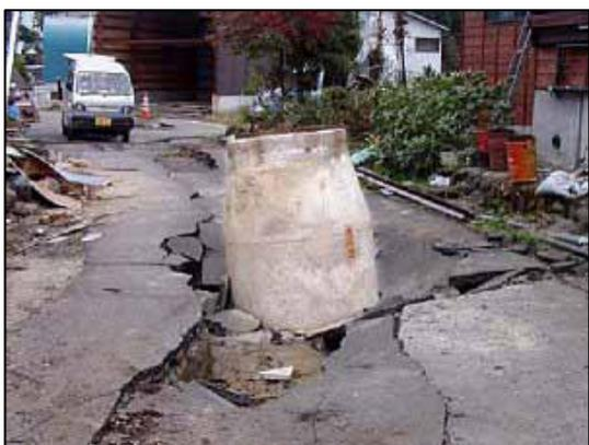
管路施設（下水道管きょ）の被害状況
