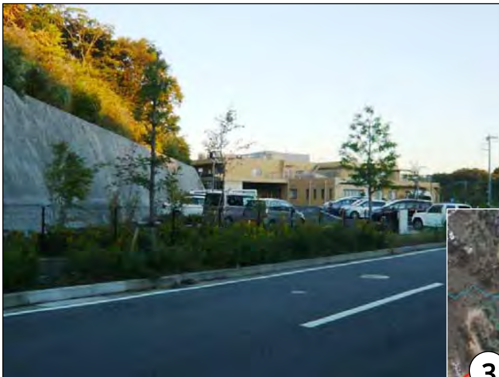
写真 B 地区(西側から)
