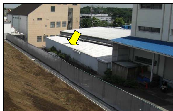
②防塵対策(メッシュシート設置)
