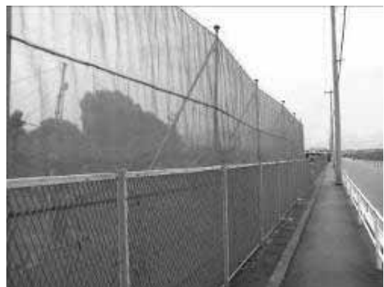
農薬飛散防止ネットの設置事例 [緑区]
