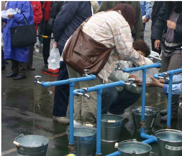
写真3-①-2 災害用地下給水タンクからの給水訓練 (発災時に地域の皆さまが自ら給水栓を設置・操作して水を確保)
