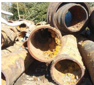
鋳鉄管(CIP) ※赤水や漏水の発生原因
