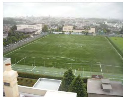
横浜FC・LEOC トレーニングセンター 〔西谷配水池上部利用〕
