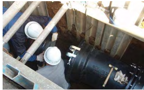
耐震管への布設替え工事
