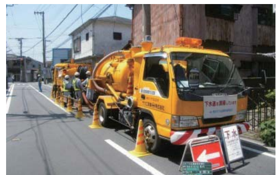
吸引車による下水道管の清掃
