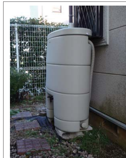
雨水貯留タンクの設置
