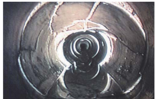
下水道管内の状態を点検・調査
