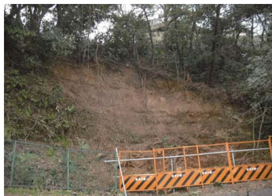
安全対策が必要な斜面地
