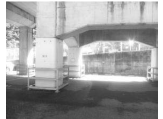
<高架橋 柱耐震補強実施済み状況>
