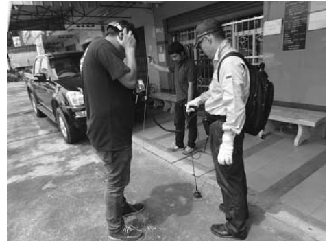
現地での漏水調査 (タイ)
