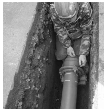
耐震管の布設状況
