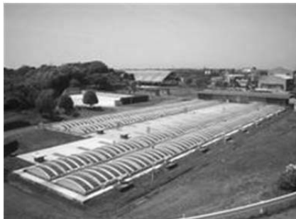
太陽光発電（小雀浄水場）
