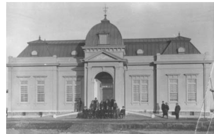
創設当時の西谷浄水場本館
