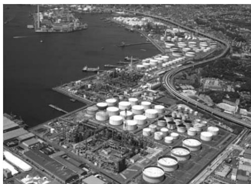
石油製品工場
