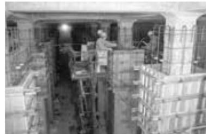
配水池の耐震化工事
