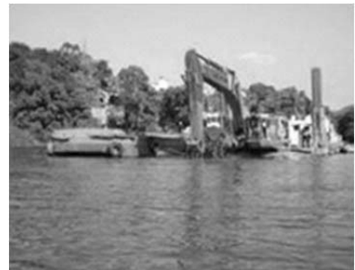
相模湖での土砂除去作業
