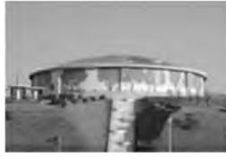
浄水場から出た水を貯留し、水の使用量に合わせて給水量を調整する施設で、市内に22か所あります。災害時には飲料水を確保します。
