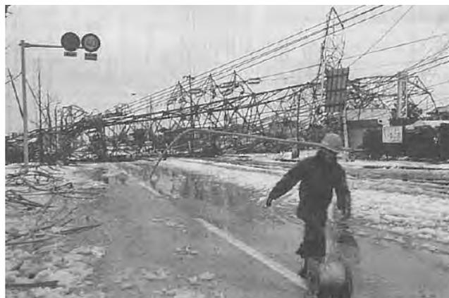
大雪による送電鉄塔の倒壊 (昭和 61 年)
