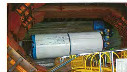
▲環状ネットワークの整備工事状況
