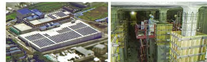
▲川井浄水場の再整備による耐震化 ▲配水池の耐震化工事
