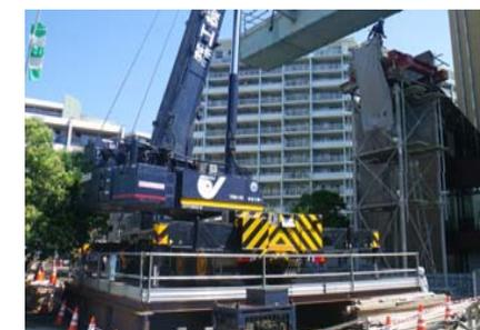
軟弱な地盤に対応した構台を使った橋桁撤去工事
