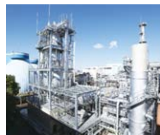
汚泥焼却炉の更新
