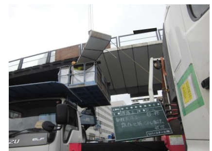
化粧パネルの撤去:桜木橋(中区)
