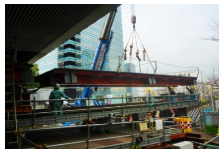
架替工事中的の新浦島橋（神奈川区）
