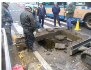
発見された空洞の修繕
