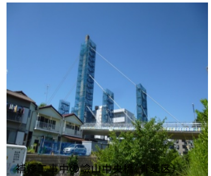
補修工事中の嶮山中央橋(青葉区)
