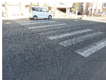
平成29年度実施予定 六角橋二丁目地区
