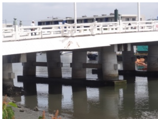
耐震補強工事中の夕照橋(金沢区)
