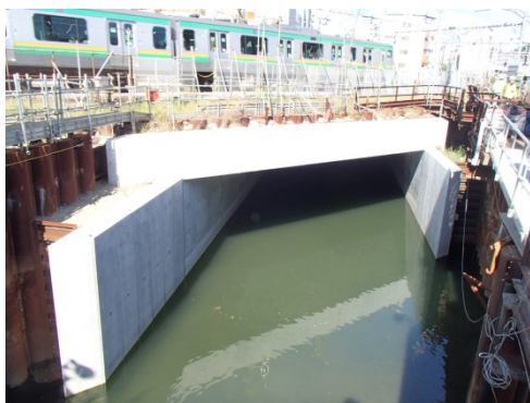
今井川 (平成29年度末に完成するJR岩間川橋梁)
