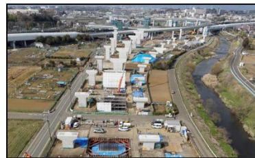
整備中の横浜環状北西線
