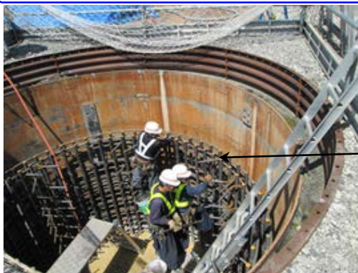
直径4.5mの基礎杭(鉄筋組立中) (平成28年6月)
