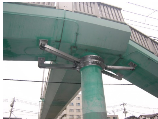
落橋防止装置:新羽歩道橋(港北区)
