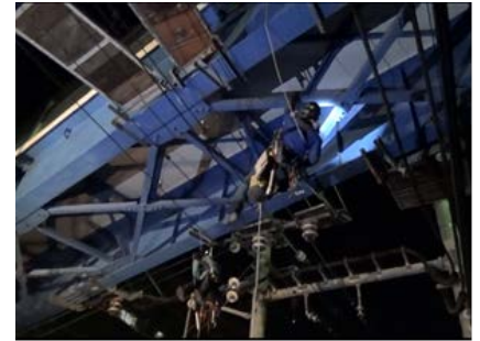
定期点検(跨線橋の近接目視)
