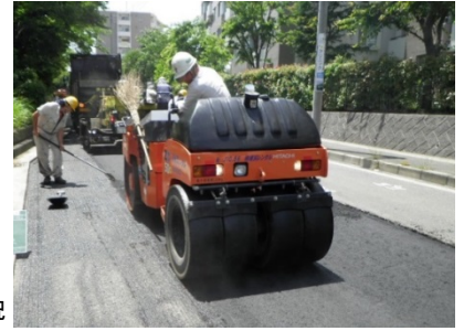
舗装修繕工事の状況
