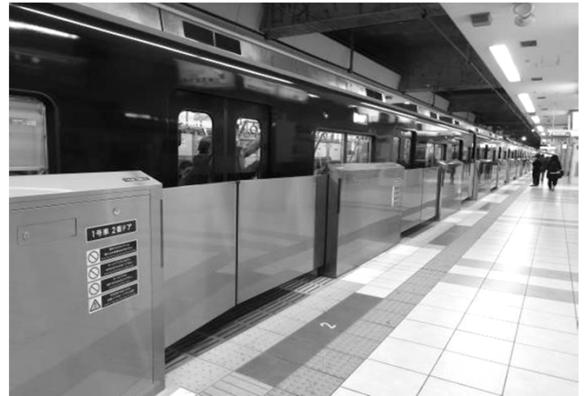
可動式ホーム柵の設置状況 (28年度整備：相鉄線横浜駅)
