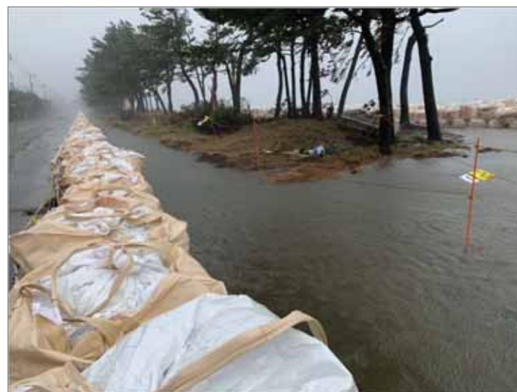
土のうによる浸水被害の防止
