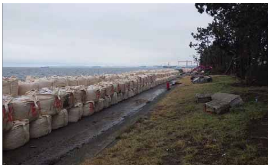
護岸の応急対応状況
