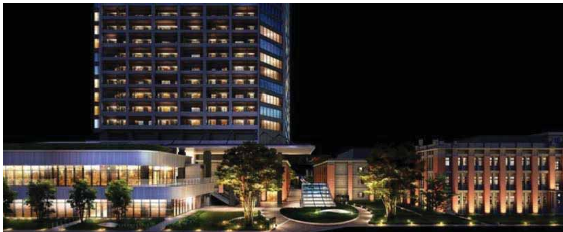
▲旧横浜生糸検査所付属生糸絹物専用倉庫の復元棟と周囲の街並み
