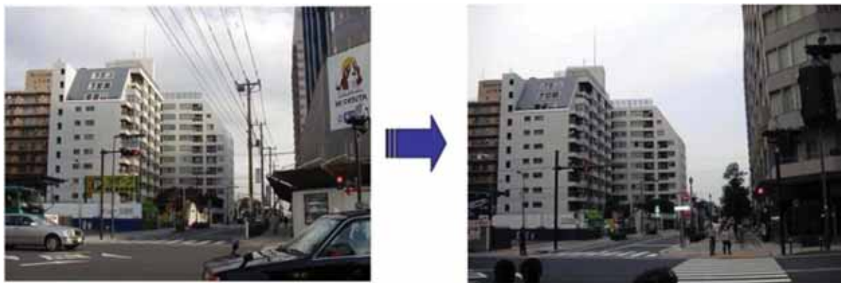
▲電線類の地中化（中区）
