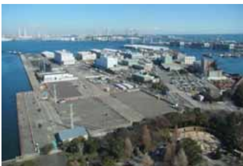
更地化の状況（令和2年1月）
