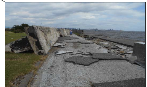
④ 本牧ふ頭 ※護岸、防波堤等の復旧
