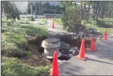
② 金沢水際線周辺 ※護岸周辺施設等の復旧
