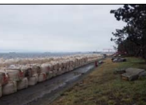
護岸応急復旧（福浦地区）
