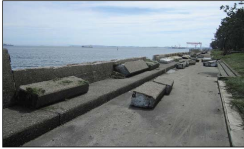
① 金沢水際線護岸 ※消波ブロックの製作、基礎工事等
