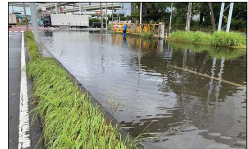
③ 大黒ふ頭 ※岸壁等の復旧、道路の嵩上げ等
