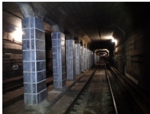
《開削トンネル中柱の補強》
