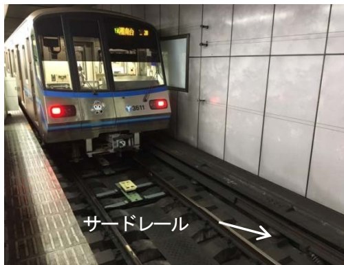
<サードレールの敷設写真>
