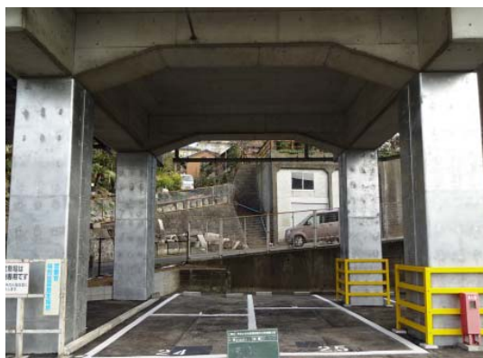
《ラーメン高架橋の橋脚の補強》
