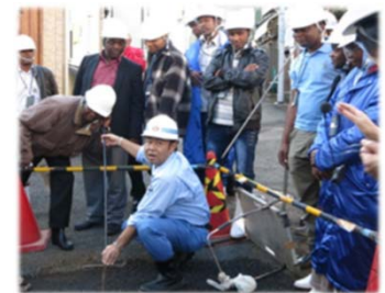
アフリカからの研修生受入れ (漏水修繕工事の様子)
