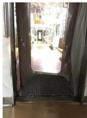
貫通扉、連結ホロの損傷
