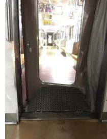
貫通扉、連結ホロの損傷
