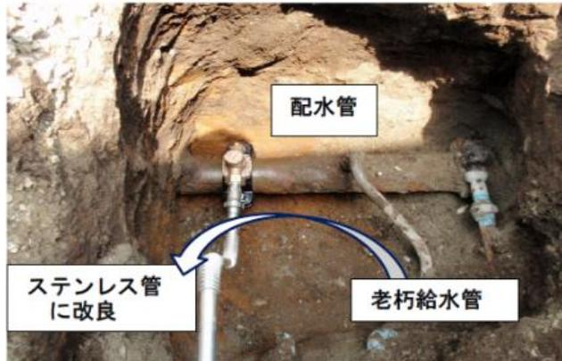
していましたが、しかし、この改良範囲の先から水道メーターまでの間の漏水発生が課題となっており、今後は改良範囲を水道メーターまでに拡大し、更なる給水管の更新・耐震化を進めていきます。
