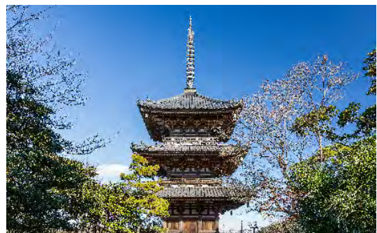
[図1-35] 旧燈明寺三重塔
