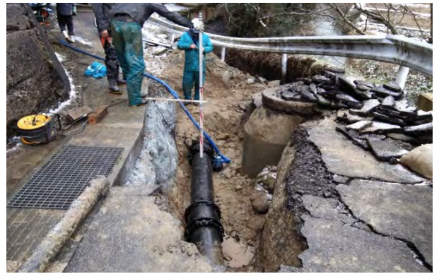
写真3：輪島市における応急復旧活動
