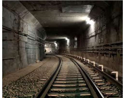
<急曲線軌道改良工事施工後>
