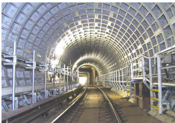
<シールドトンネルの補修>
