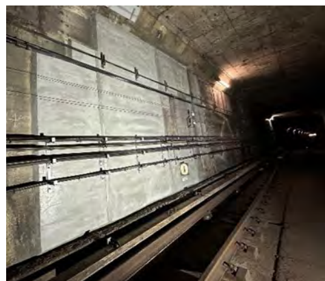
<開削トンネルの補修>
