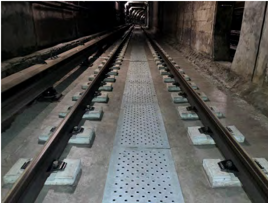
<軌道改良工事施工後>
