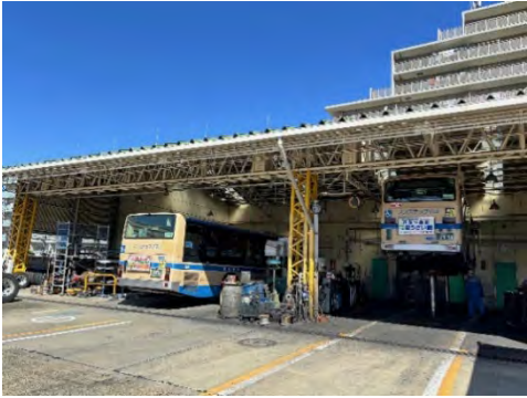
<緑営業所車両整備工場>
