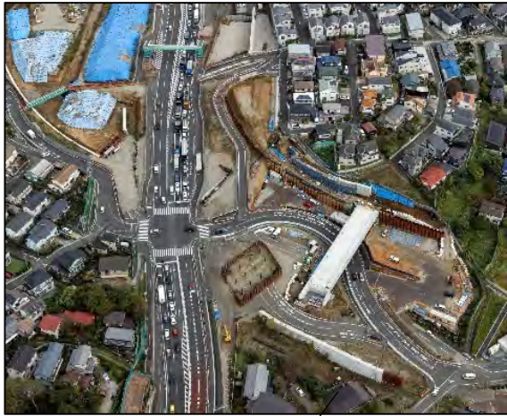
(仮称)戸塚IC築造工事(戸塚区原宿)国道1号吹上交差点付近
