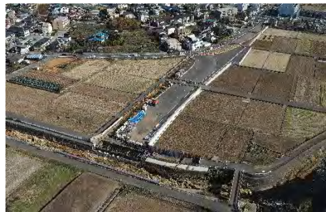
奈良川を横断する橋梁工事
