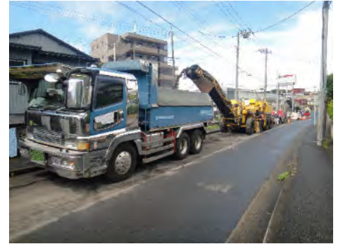
舗装修繕工事の状況(旭区)
