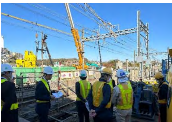
有識者による現場視察(発進立坑部)
