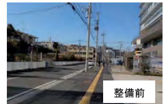
無電柱化の状況 (港南区役所)
