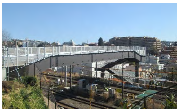
樹源寺跨線人道橋が開通しました。 (令和6年3月開通)
