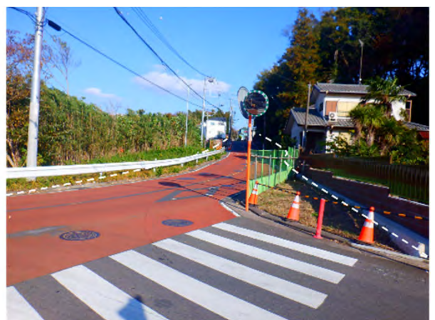
歩道整備・交差点改良 市道下瀬谷第438号線(瀬谷区宮沢三丁目)
