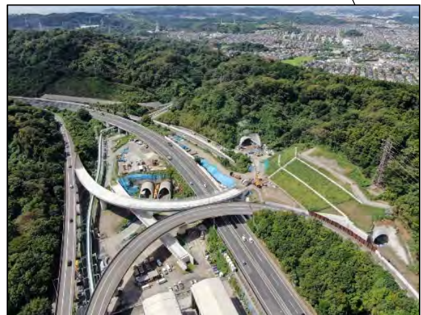
釜利谷JCT改築工事(金沢区釜利谷町)横浜横須賀道路釜利谷JCT付近
