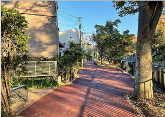
舗装の改修 (栄区:花や鳥、豊かな自然に出会ういち川ルート)
