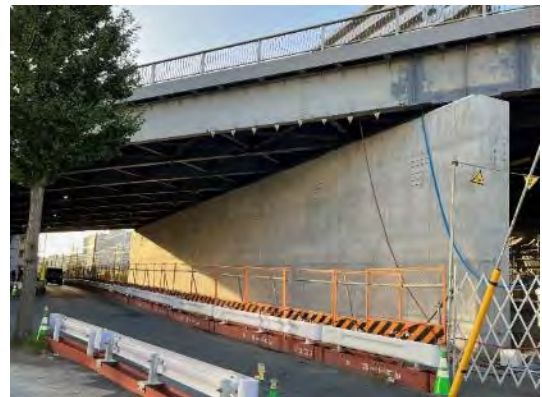
耐震補強工事：新横浜陸橋（港北区）
