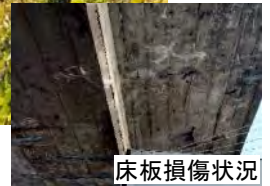
計画的な補修: 第1柳明橋(泉区)
