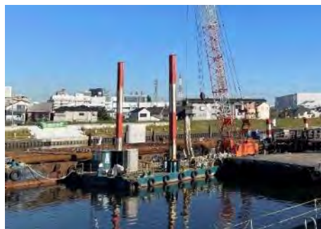
河川工事状況(橋脚を施工中)
