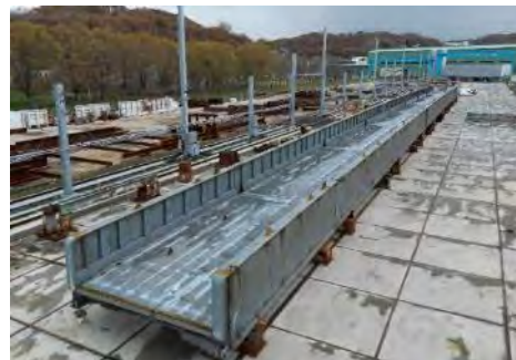
桁部製作状況
