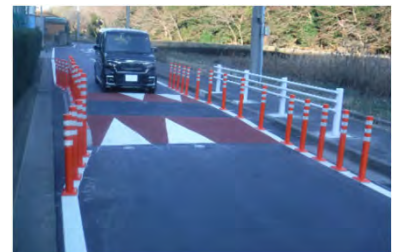
通学路の交通安全対策 速度抑制対策: 瀬谷区原小学校周辺
