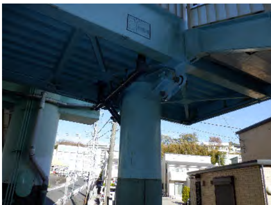
峰沢町歩道橋（保土ヶ谷区）：横変位装置 令和5年7月完成
