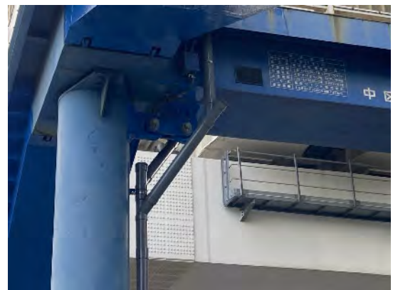
錦町第三歩道橋（中区）：落橋防止装置 令和5年7月完成
