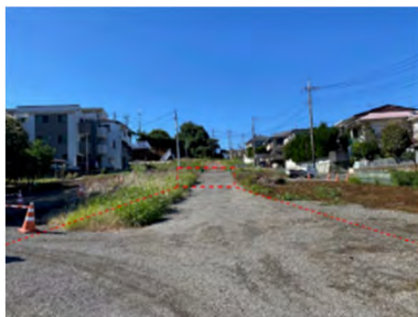
山下長津田線【鴨居地区】(緑区)
