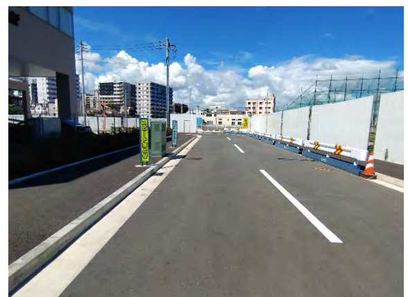
地区内道路の一部完成
