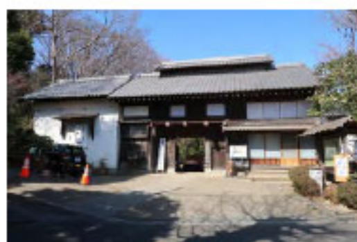
長屋門公園 (写真は旧大岡家長屋門)
