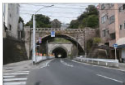
桜道橋（手前）と山手隧道（奥）
