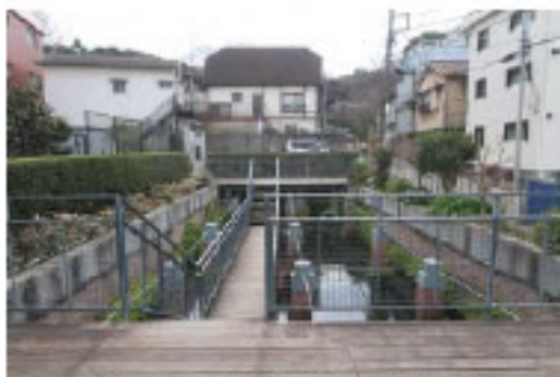
ジュラール水屋敷地下貯水槽
