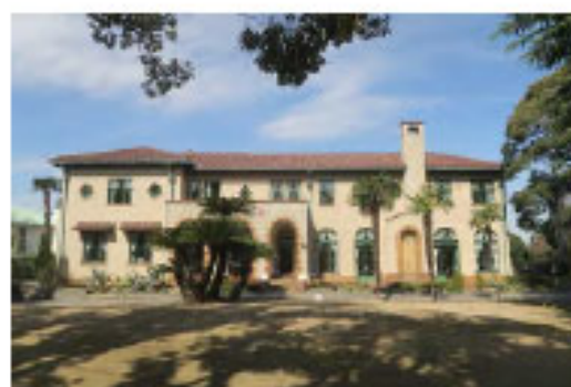
ベーリック・ホール
