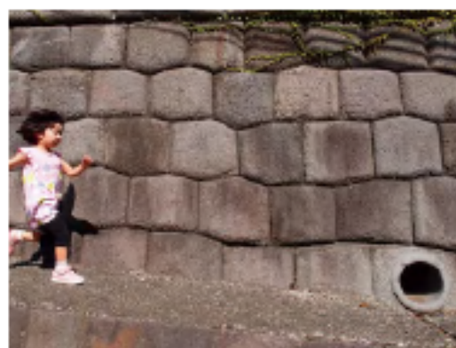
旧平沼専蔵別邸亀甲積擁壁
