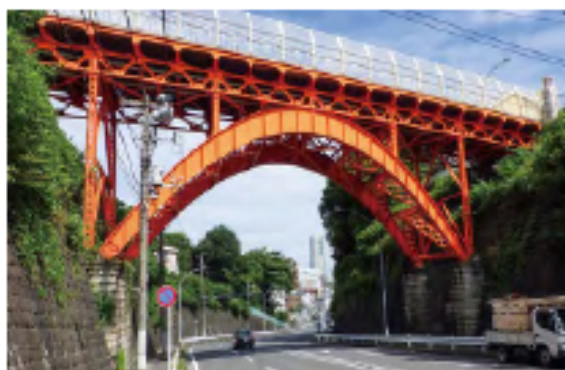
打越橋(震災復興橋梁)
