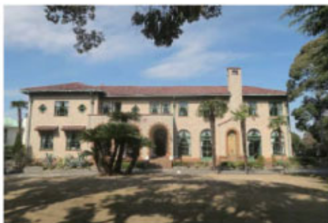
▲ベーリックホール（中区）
