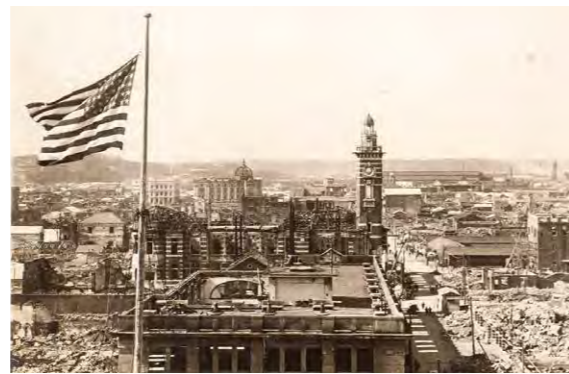
横浜中央電話局舎からみた震災被害全景(横浜開港資料館所蔵)
